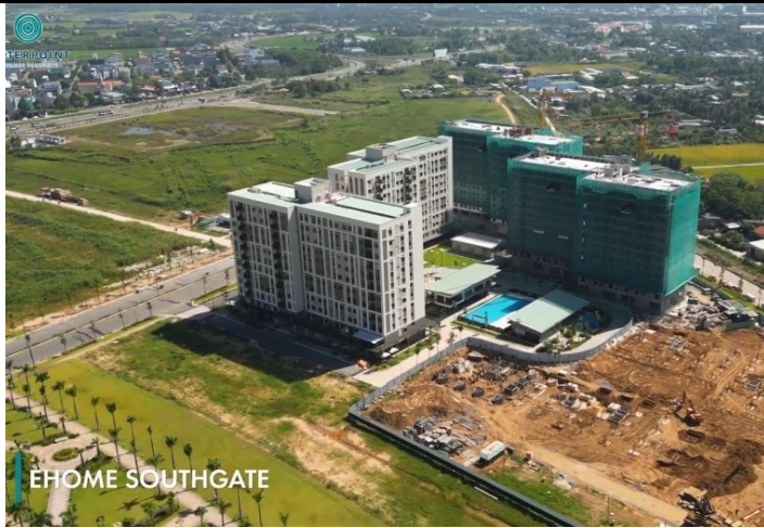
Hình 16: Phân khu Aquarina, Ehome Southgate GD 2 (đã cất nóc), Ehome Southgate GD (đang thi công móng)...
